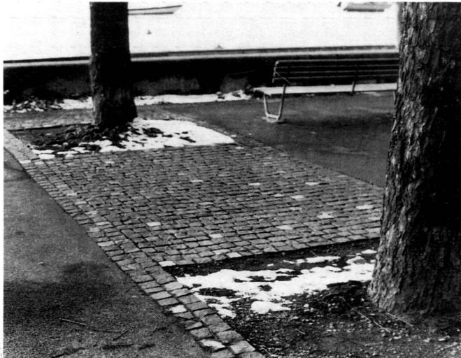
Entfernen der luftabschliessenden Beläge, Vergrössern der atmungsaktiven Baumscheiben, Einbauen von Substrat und Be pflanzung oder Ansaat derselben. Abdecken der Baumscheiben mit luftdurchlässigen Verbundsteinen, Pflästerungen mit grossen Fugen oder Kiesbeläge. Einbauen von Belüftungs- und Bewässerungseinrichtungen. Wurzelraumbehandlung mittels Injektion von Luft, Bodenhilfsstoffen und Bodenentgiftungsmitteln sowie Pufferung der Schadstoffe im Boden.
