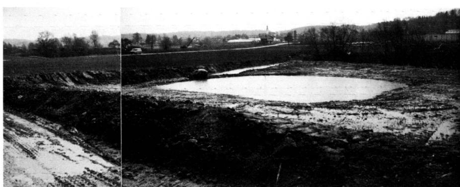
Nachträgliches Ausmulden einer ausgedehnten Auffüllungsfläche zum Sammeln des Oberflächenwassers; Ausgestaltung des Überlaufes als breite «Wagenspur» mit Einmündung in einen Filterkörper, damit keine Feinteile in das tiefliegende Laichgewässer eingespült werden können. Rändliche Ausbildung eines Mähstreifens, der innen durch einen noch zu bepflanzenden Erdwall begrenzt wird.
