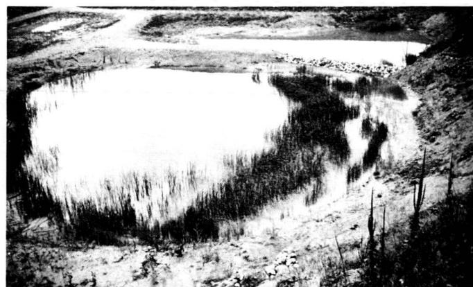
A gauche: Reconstruction d'un talus avec taillis; au pied création d'un site spécial avec blocs de pierre, tandis que d'autres endroits, jusqu'à mi-hauteur du talus, ont été couverts d'une couche de sable de 50cm au moins. De la plantation de la crête du talus, on ne distingue nettement que deux chênes.
