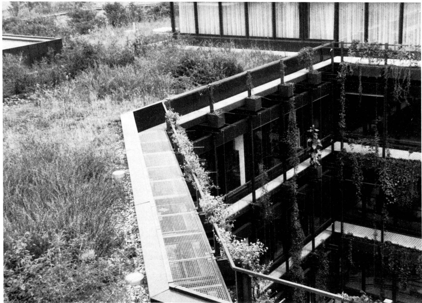
Zusammenhängende Begrünung vom Erdgeschoss über die Fassaden bis hin zum Dach.
