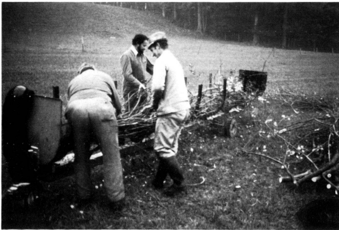
3 Mit der «Wedelmaschine» aus der nahen Sägerei werden 4 m lange Weiden-Uferfaschinen gebündelt.
