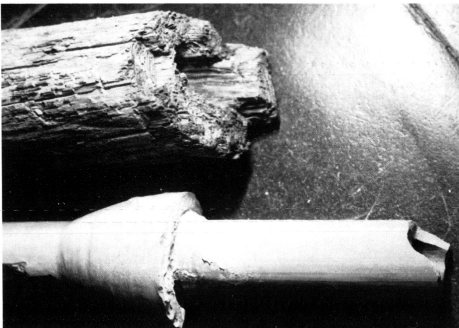
Oben: Holzwasserleitung («Tüchel», Bohrweite 5–6 cm); unten: Tonwasserleitung, etwa um 1830.
