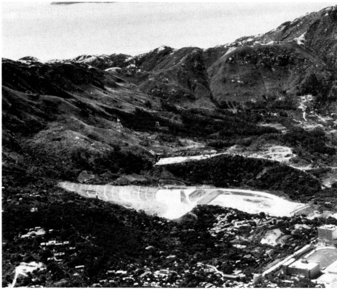
Links: Castle Peak. Der sanierte Hang 1980 nach dem Ansäen. Erodierter Grat im Hintergrund. Foto: Survey Division Hong Kong Government
