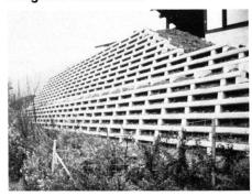
Stützmauer mit Variant-Elementen nach Fertigstellung vor Bepflanzung.
