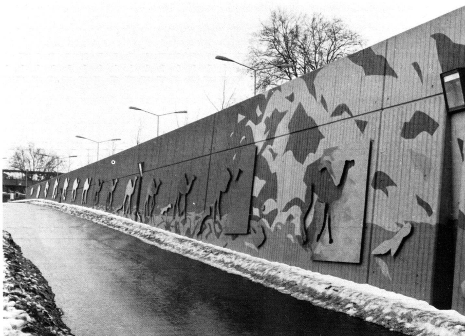
Stützmauergliederung mit Schlitz (Nischen für Kletterpflanzen und Beleuchtung). Künstlerische Gestaltung: St. Kauffungen.
