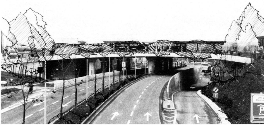
«Grüne Brücke» – als ein Bestandteil des Parkes konstruiert, Stand November 1984.
