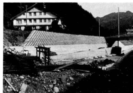
Wohltuend heben sich Silidur-Löffelstein-Mauern von herkömmlichen Betonmauern ab. Weil sie sich eben nicht abheben, sondern mit ihrer natürlichen Umgebung harmonieren, denn die sichtbare Front tritt mit zunehmender Begrünung mehr und mehr in den Hintergrund.
