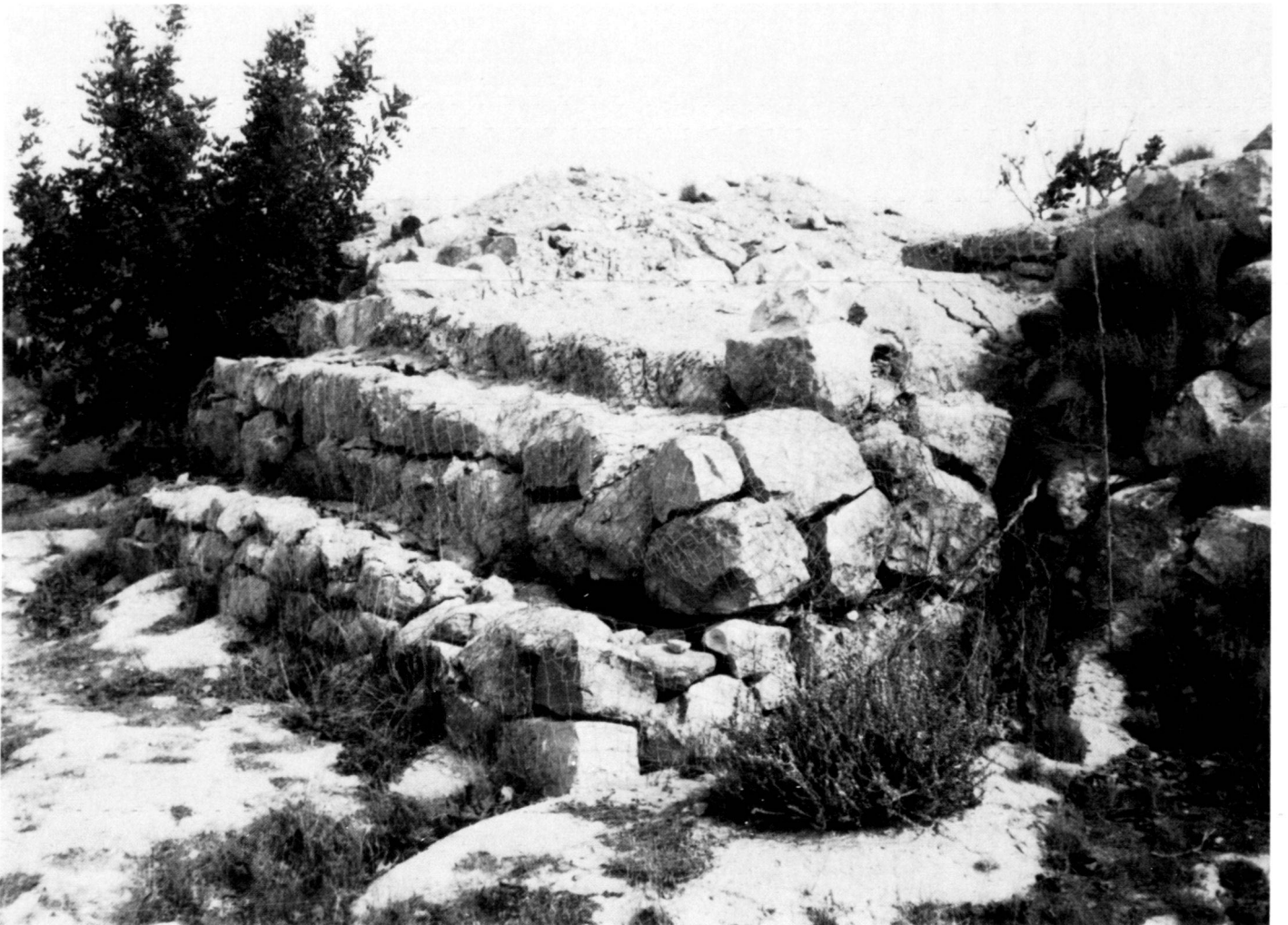
Alte Treppenschleuse im Park. Das Wasser wurde von den Stufen in seiner Strömungskraft gebremst.
