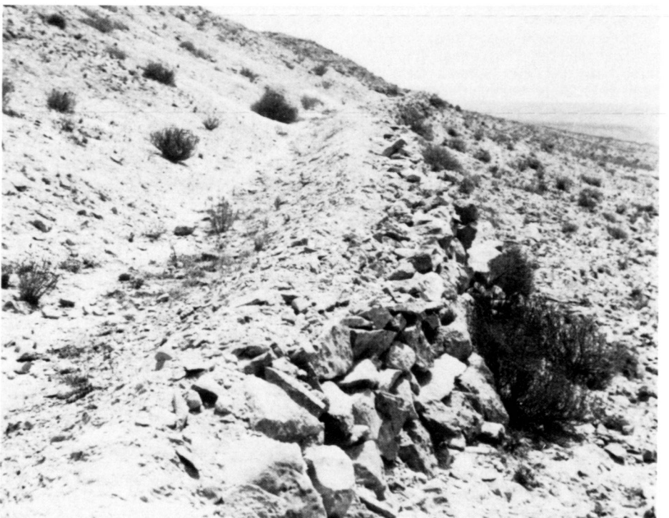
Queransicht eines Zuleitungskanals, der das Flutwasser von den Hängen sammelt und aus dem Sammelgebiet in die Farmeinheiten leitet.
