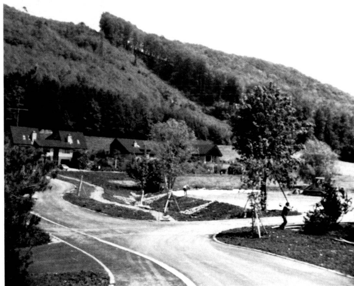
A gauche: Un des hauts seuils maçonnés avec bassin d'amortissement et abri à poissons. A gauche, la promenade avec revêtement naturel et les bancs du syndicat d'initiative.
