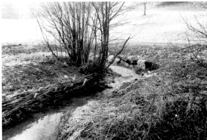
Links: Faschinenverbau vor dem Austrieb der Weiden. Rechts: Faschinenverbau nach Austrieb der Weiden.
