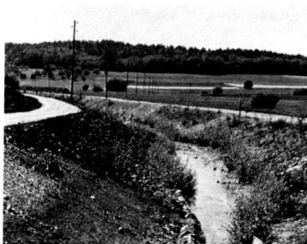
Die Bilder zeigen den Bachlauf westlich der Brücke Wilenholz mit varierender Breite der Bachsohle und ungleichmässiger Böschungsneigung. Bild 1 wurde im März, Bild 2 im Juni und Bild 3 im August 1982 aufgenommen. Die Sequenz zeigt, wie rasch die Weidenfaschinen ausgeschlagen haben und gewachsen sind und wie die Begrünung auf den nichthumusierten Böschungen dank geeigneter Ansatzmischung rasch erfolgte.
