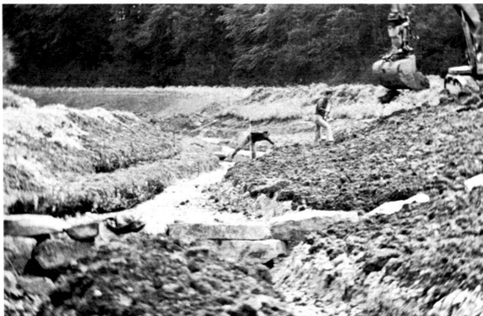
Links: Im Frühling 1980 beim Bau der Querriegel und dem Faschineneinbau.
