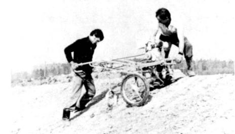
Für jeden einzelnen Baum und Strauch wurde mit dem benzingertriebenen Bohrer ein Loch in die nicht humifizierte Böschung gegraben.
