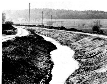
Les images présentent le cours du ruisseau à l'ouest de la Wilenholz bridge, avec une largeur variable du radier et des pentes de talus inégales. La fig. 1 a été faite en mars, la 2 en juin et la 3 en août 1982. La séquence montre avec quelle rapidité les fascines d'osier ont cru et se sont développées et combien le vert est rapidement apparu sur les talus sans humus, grâce au mélange de semences approprié.
