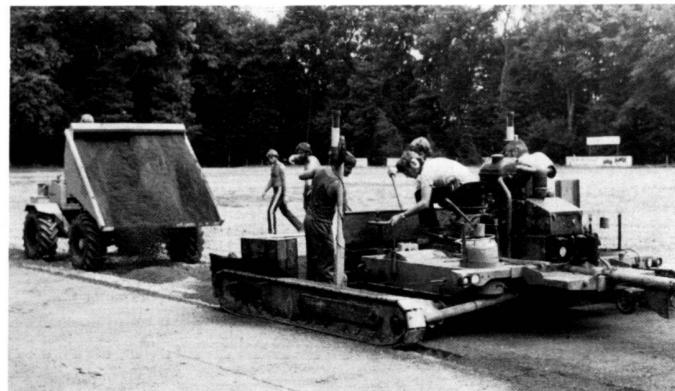
*A gauche:* Transport de la couche de base du gazon (couche d'usure) sur rails, par tombereaux.
