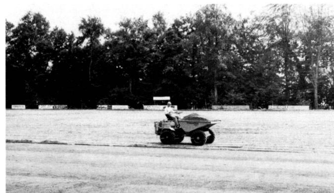
*Links:* Transport der Rasentragschicht (Verschleiss-Schicht) auf Schienen mittels Dumper.
