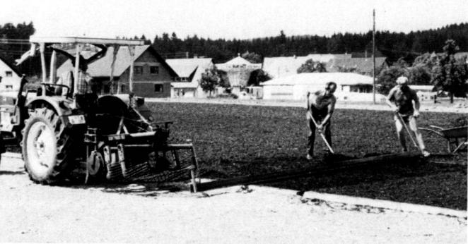
*Links:* Abziehen der Belagsschicht mit einfachen Hilfsgeräten, zum Beispiel Kartoffelroder mit Abziehplatte.
