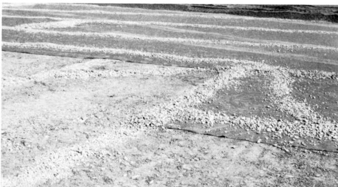
*Links:* Abdecken der Flächen mit einer Vliesmatte oder je nach Untergrund Filtersand.
