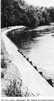
40 cm) nach Verlegen der Matte eingeschlagen werden (im Überschwemmungsbereich 1 Pfahl/m² sonst 1 Pfahl/1,5-2 m²), Endbereich entsprechend dichter;
