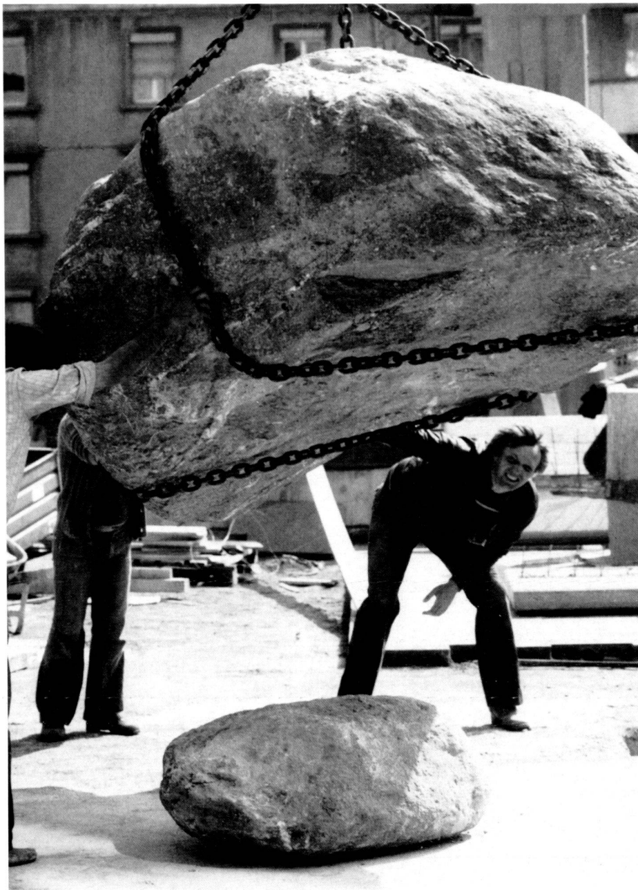
Edi Brunner (rechts) beim Bau des «Steinschlags» und des «Chempe»-Brunnens. Foto Leonardo Bezzola
