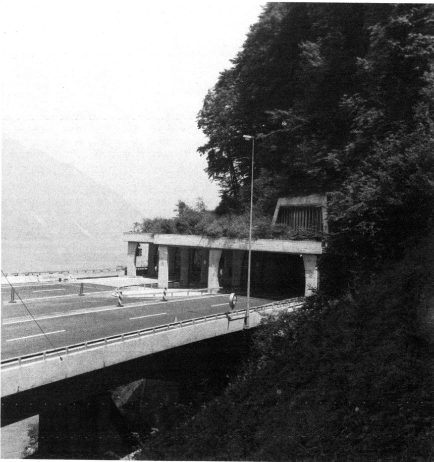
Nordportal Seelisbergtunnel: Portaldecke und Felswand, mit 2jähriger Bepflanzung. Die Felsanker sind bereits eingewachsen. (Fotos Stern)
