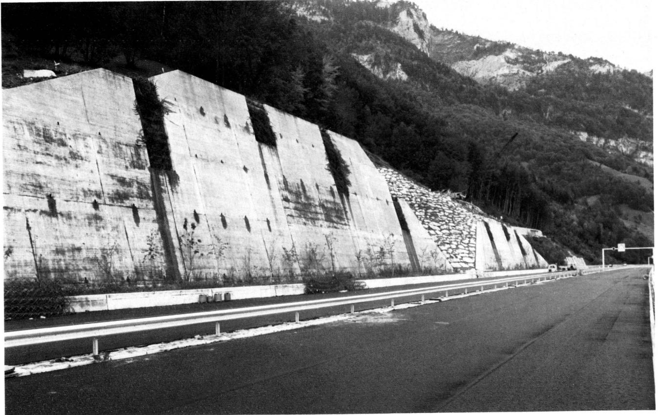
Diese 16,30 m über die Fahrbahn reichende Wandmauer wurde mit bepflanzten Schlitten aufgelockert. Am Fusse der Mauer ist die Pflanzrabatte sichtbar. Zur Unterstützung für nicht selbstkletternde Pflanzen wurden die untersten 4 m der Wandhöhe mit einem Diagonalgeflecht versehen. An der Wandoberfläche ist der Ansatz von Patina bereits erkennbar.
