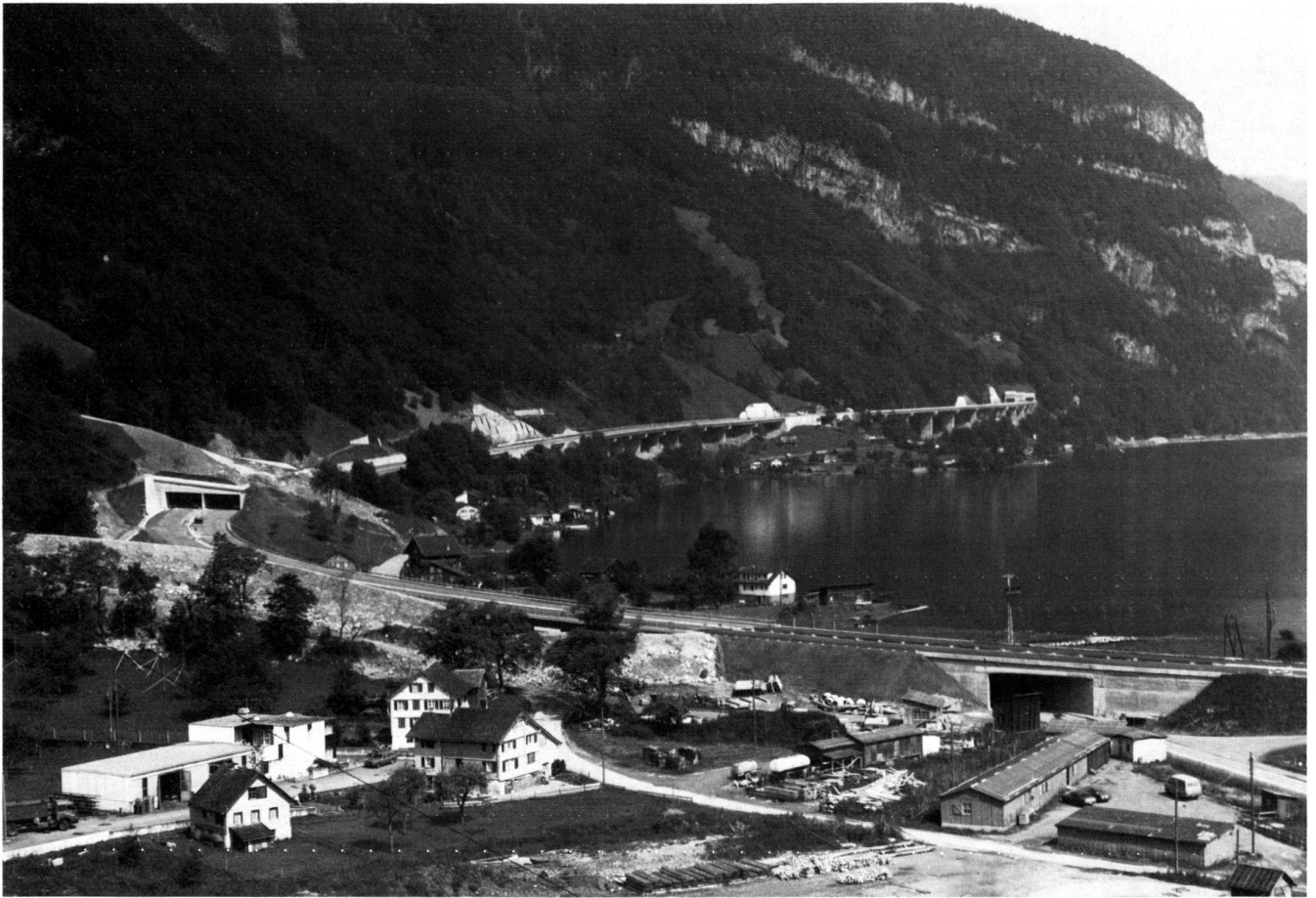
Die vom See zum Südportal des Seelisbergtunnels steigende Nationalstrasse ist in ihrer Lage bestimmt durch die Kreuzungen mit Lawinenzügen und Wildbächen und den steilen Felspartien. Die im Bild sichtbare Länge der Autobahn ist 2,1 km. (Foto Studio)
