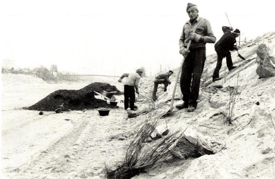
Forstarbeiter bei den Pflanzarbeiten am «argine insommergibile». Die Fugen wurden mit «Lita» ausfüllt, die Pflanzlöcher mit Locheisen vorbereitet und mit Humus angereichert.
