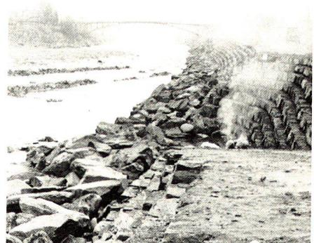
Im Vordergrund der stufenartige Aufbau des überflutbaren Dammes, der Blockwurf für die Flussfauna und die Zugangsrampe. Gegen den Hintergrund der unüberflutbare Damm, mit flachliegenden Granitblöcken befestigt. Zwischen den Dämmen die Golena.
