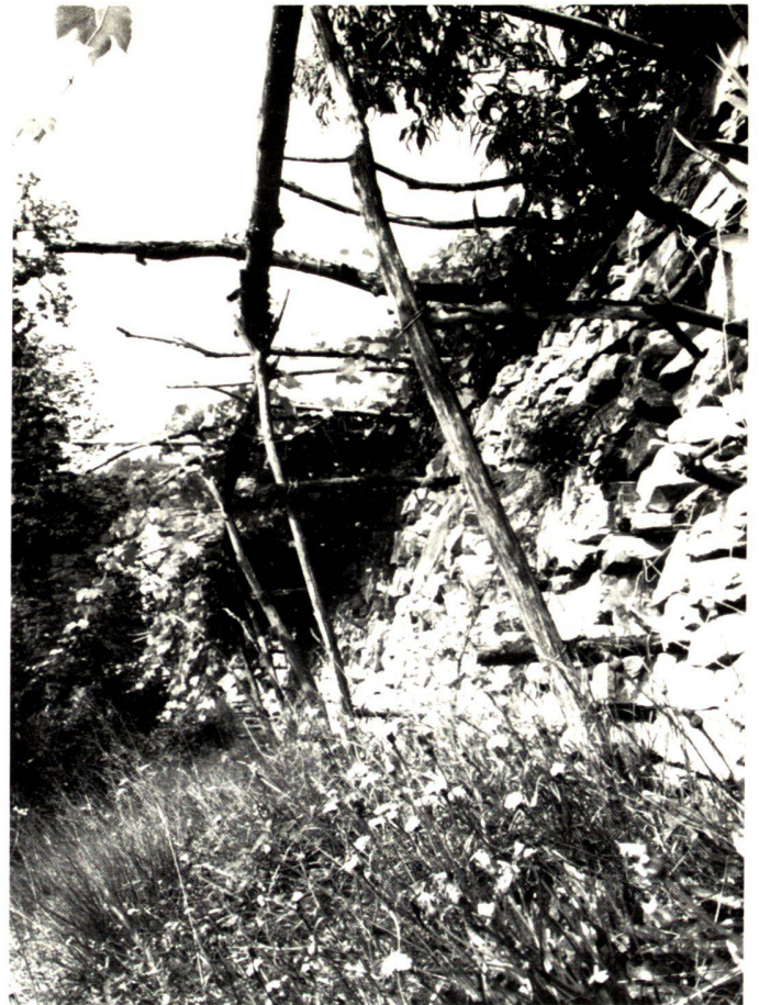
En haute à gauche: Première mesure importante pour l'aménagement d'un jardin habitable sur le coteau, la construction d'un mur de soutènement approprié du point de vue du matériel et des conditions locales.
