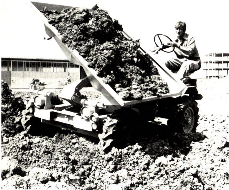
Links: Mit solchen Kleingeräten bestehen echte Möglichkeiten der Entwicklungshilfe — zur Verbesserung der Arbeitsbedingungen, der körperlichen Schwerstarbeit.
