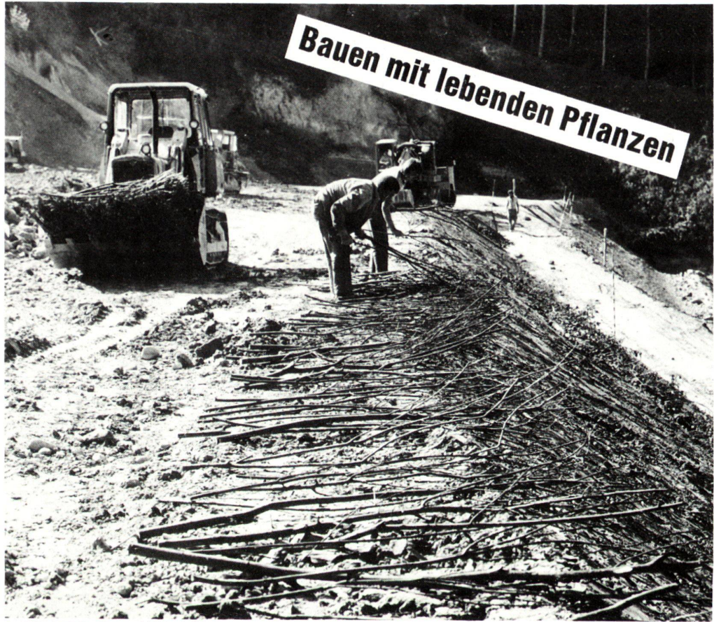
Autobahnböschung N6 bei Bern Stabilbauweise mit Buschlagenbau in Zusammenarbeit mit dem Kantonalen Autobahnamt Bern
