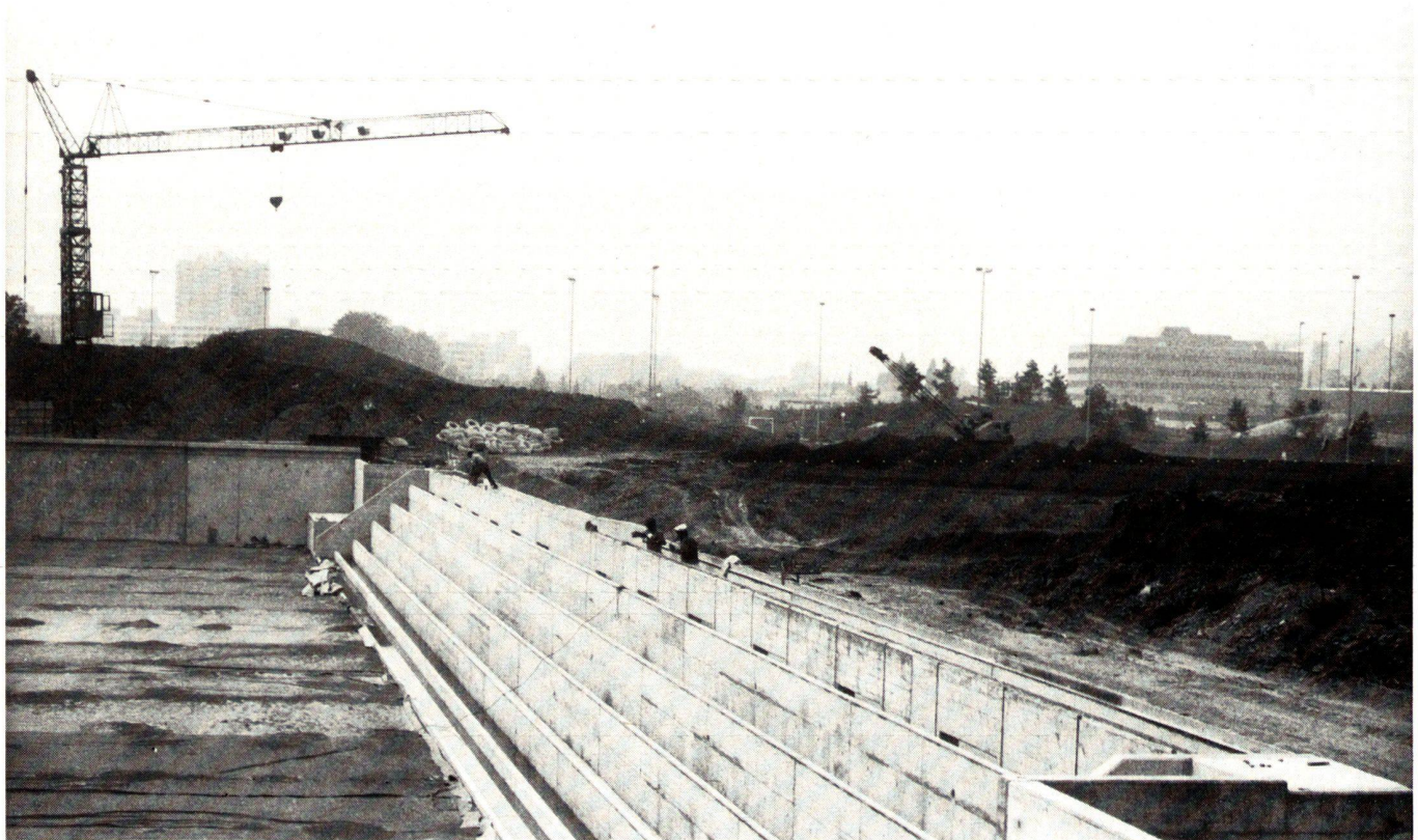
Fig. b) Bassin d'enrichissement I en voie de construction. A l'arrière-plan, collines des puits de captage des eaux souterraines A et B. Août 1978.
