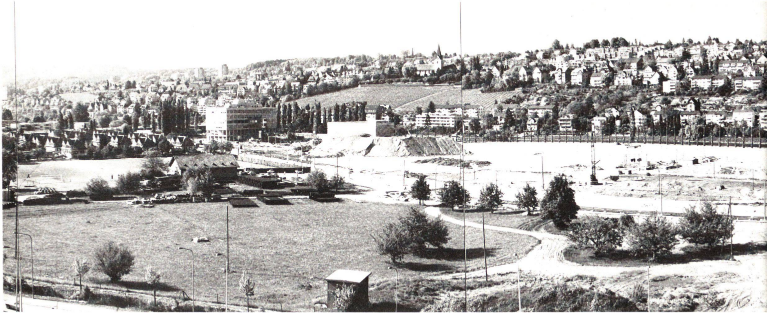
Das Hardhof-Areal im Bauzustand Frühjahr 1976. Bild: Büro Neukom, Garten- und Landschafts- architect BSG/SWB, Zürich
