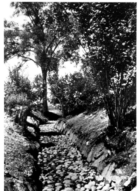
Ausbau des Jonenbaches bei Oberlunkhofen kurz nach Fertigstellung. Durch subtile Anpassung des Bachlaufes an die bestehende Situation konnte der Gehölzbestand weitgehend erhalten werden. Foto: E. Kessler
