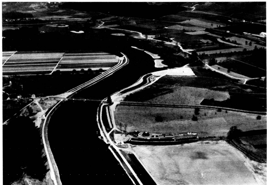
Brücke Rottenschwil und Flachsee Unterlunkhofen. Comet-Foto, Zürich
