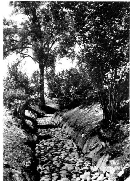
Ausbau des Jonenbaches bei Oberlunkhofen kurz nach Fertigstellung. Durch subtile Anpassung des Bachlaufes an die bestehende Situation konnte der Gehölzbestand weitgehend erhalten werden. Foto: E. Kessler
