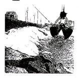
Polyfelt TS als Trenn- und Filterschicht zwischen Uferböschung und Steinwurf – dagegen kommt die Strömung nicht an.
