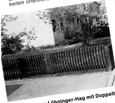
Pfahlwand als Sicht- und Schallschutz (Variationen in Palisadenwand oder Rebsteckenhag)
