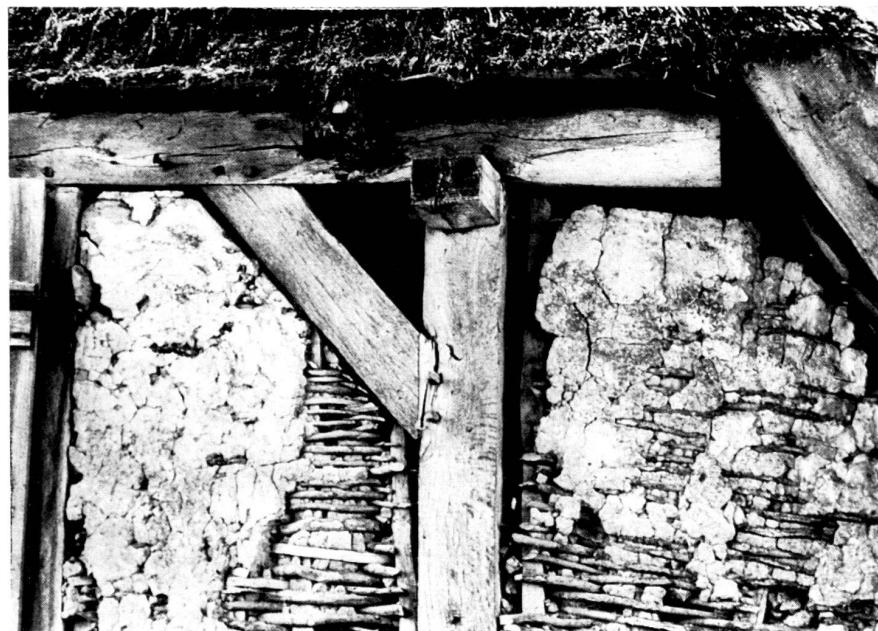
Rahmenbauweise mit vereinzelt liegenden Fenstern, oft mit Eckverstrebungen und Felderausfachung, früher durch Weidengeflecht mit Lehmbezug, später mit Ziegelverbänden.
