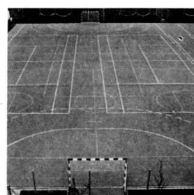
RUB KOR Sportplatzbeläge sind elastisch und witterungsbeständig, eine 25 mm dicke Schicht aus Bitumen, Kork und Gummi wird mit roter oder grauer Schlämme versiegelt.
