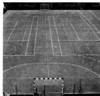
RUB KOR Sportplatzbeläge sind elastisch und witterungsbeständig, eine 25 mm dicke Schicht aus Bitumen, Kork und Gummi wird mit roter oder grauer Schlämme versiegelt.
