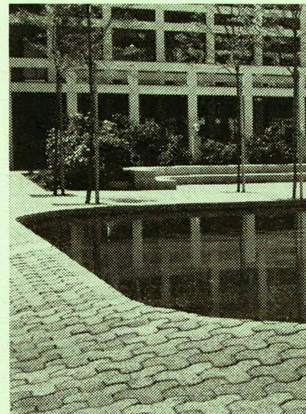
Mit WB-Verbundsteinen (AG für Steinindustrie Rozloch/NW) lassen sich Pflasterungen ohne durchgehende Fugen und mit bester Verbundwirkung erstellen (besondere Eignung für Flächen, die auch mit schweren Motorfahrzeugen befahren werden müssen).
