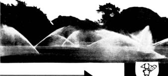
Perrot-Versenkregner unsichtbar im Boden eingebaut
