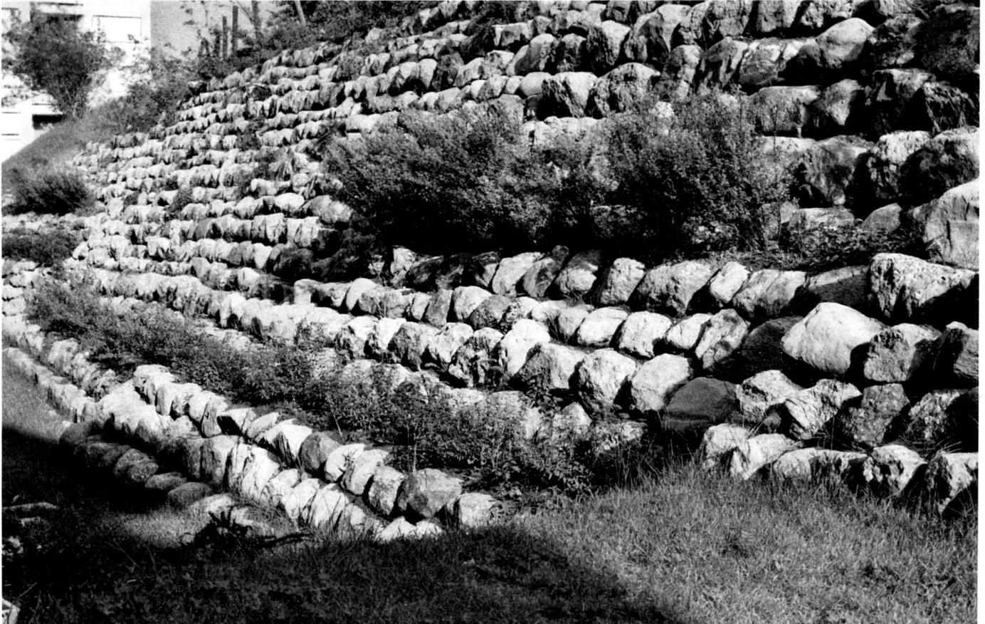
Diese Steilböschung mit Grubensteinen, an Stelle einer Stützmauer gebaut, ergibt einen grösseren Licht- und Sonneneinfall. Die wechselnden Stufen sind mit wilden Rosen, Ampelopsis und Forsythien bepflanzt.
