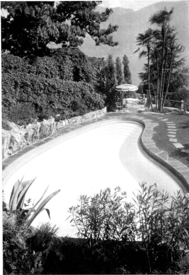
Privates Schwimmbad in Ascona/Tessin Bassin dreimal gestrichen mit ICOSIT K 25 S weiss
