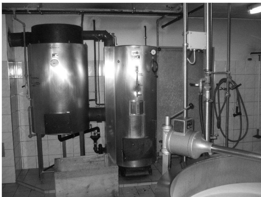
La vanaun a vapur ei sillia fotografia da maun dretg. Giudem ha la vanaun ina porta per far fiug ed ei colligiada cun in boiler d'aua caulda (seniester). Quei boiler vegn scaldaus culla vapur dalla vanaun cu la vapur vegn buca gest duvrada per scaldar la caldera.
