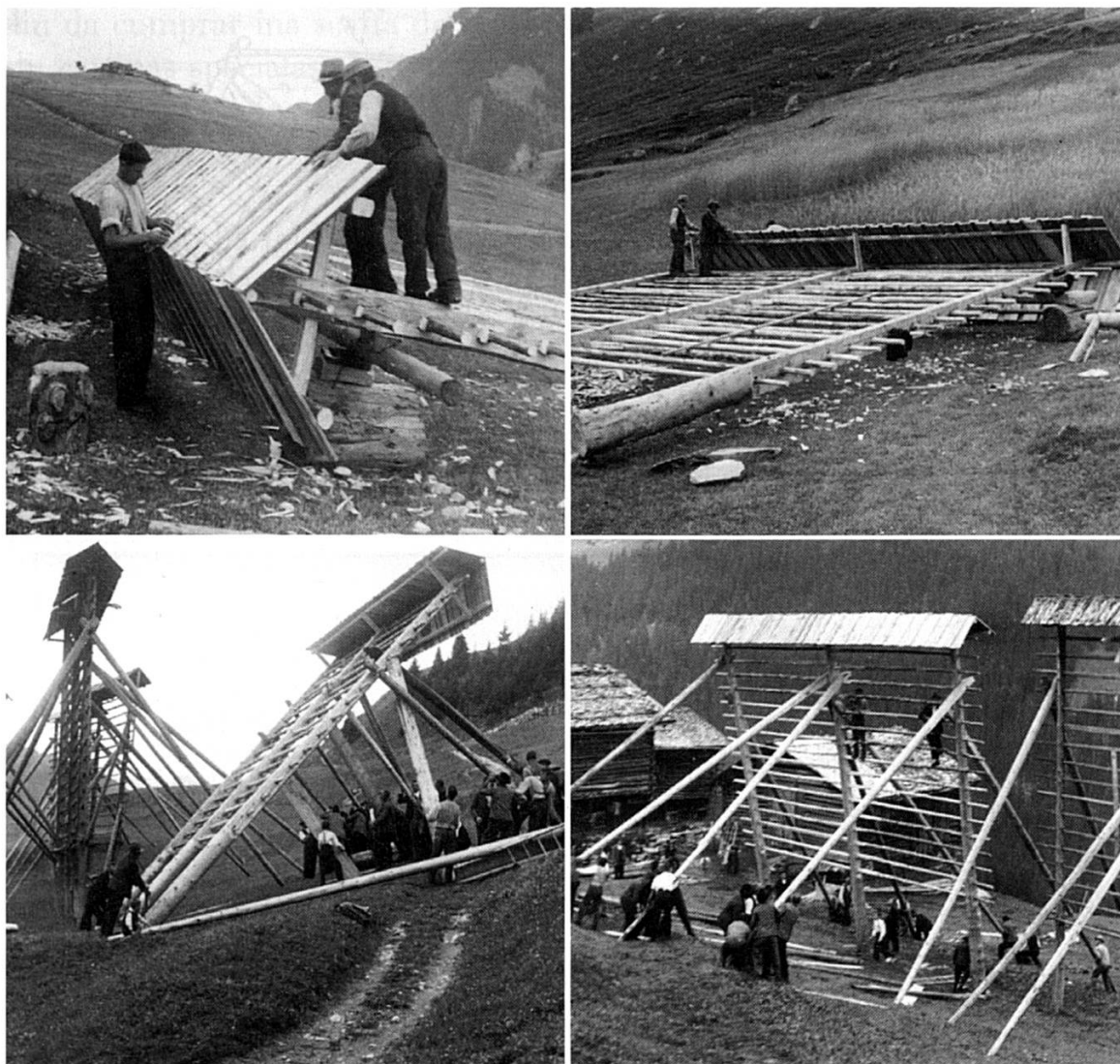
Quater fotografias d'Alfons Maissen che muossan, co in chischner ei vegnius construius e derschius si la stad digl onn 1938 si Mumpé Tujetsch.
