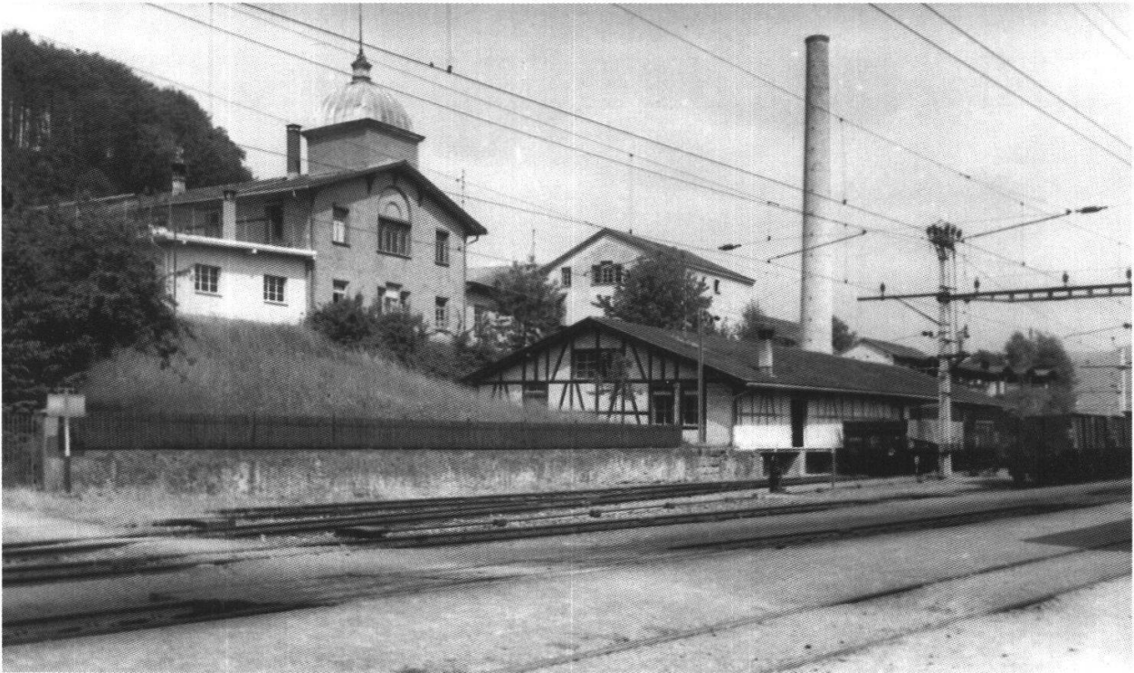
Abb. 1: Gipsfabrik Felsenau, Blick gegen den Bahnhof Felsenau (ca. 1950)
