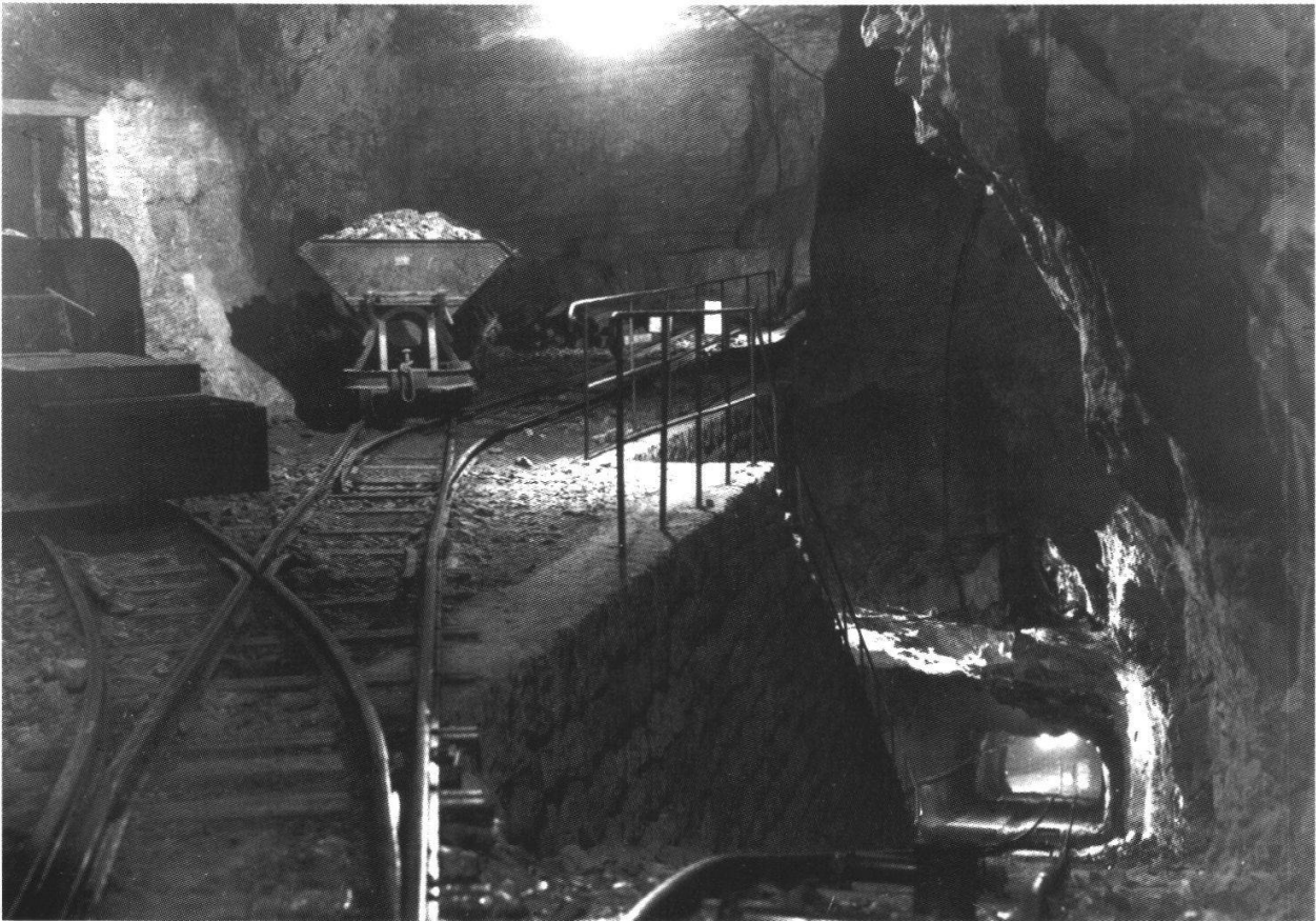
Abb. 2: Der Bremsberg von der Sohle A nach C (1951)
