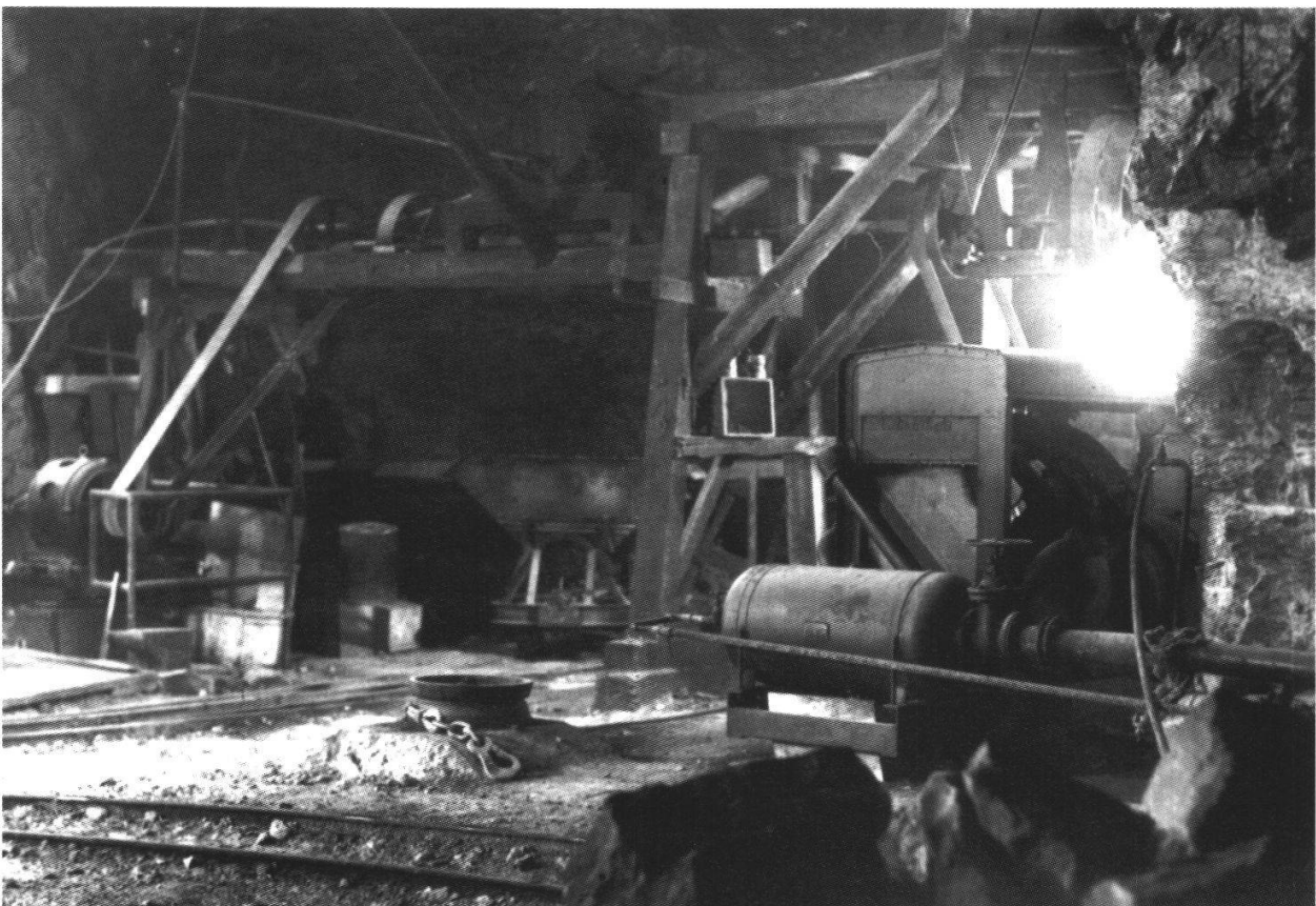
Abb. 3: Maschinenkaverne in der Sohle A vor dem Umbau 1950
