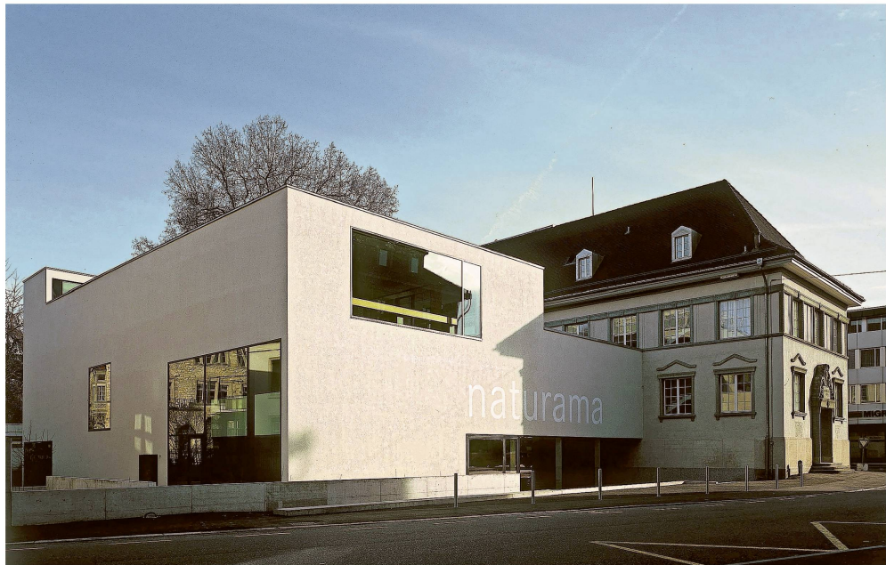
Aarau Feerstrasse 17: Der Naturama – Neubau 2002 an das Gebäude von 1922 passend angefügt (Foto Naturama Aargau).
