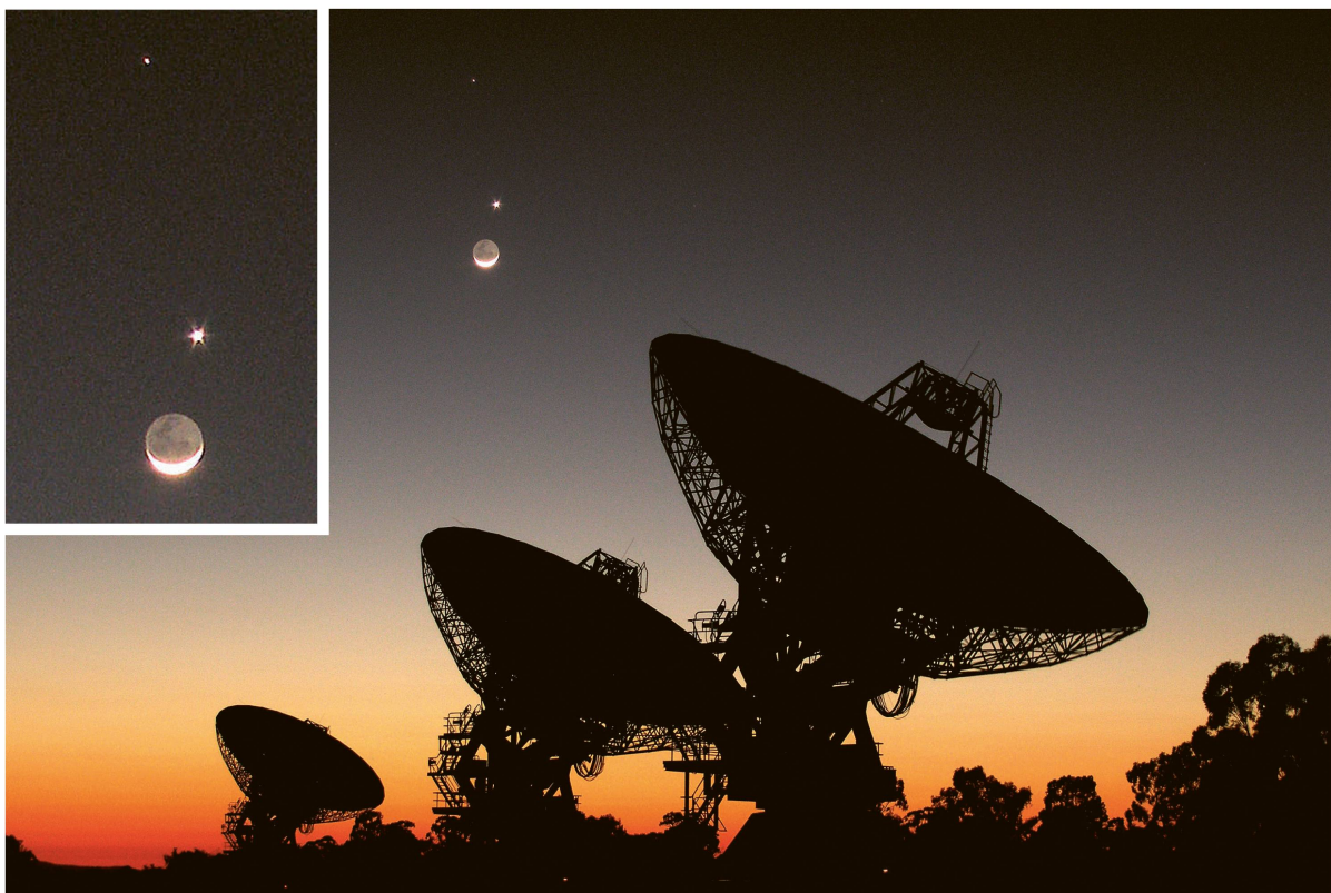
Abb. 2: Drei der sechs 22-Meter-Radioteleskop-Antennen des 1988 errichteten Paul Wild Observatoriums bei Narrabri in Australien kurz vor dem Sonnenaufgang. Neben dem Mond ist die Venus zu sehen, am oberen Bildrand zudem der Merkur. 5 der 6 Teleskope sind auf einer West-Ost orientierten 3 km langen Schiene verschiebbar. Das 6. Teleskop steht fix auf derselben Linie in 3 km Entfernung vom Ende der Schiene. Die Empfänger wurden 2007 auf 7 mm kurze Wellen aufgerüstet. Die Auflösung beträgt seitdem in einer Dimension \lambda/D = 1,2 \mu\text{arc} = 67 \text{ Mikrograde} oder 0,24 \text{ Bogensekunden} ( D = 6 \text{ km} ). Bild: CSIRO, CC BY 3.0
