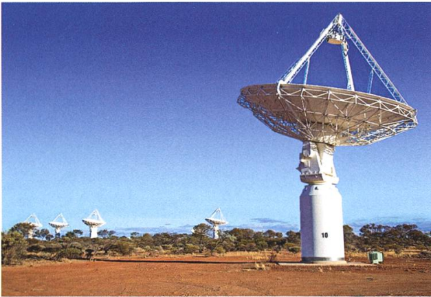
Abb. 6: Murchison-Observatorium in Westaustralien. Das Bild zeigt 5 von insgesamt 36 Parabolantennen mit je 12 m Durchmesser, die zu einem Radioteleskop-Array zusammengeschlossen wurden, dessen Auflösung einer Antenne mit etwa 6 km Durchmesser entspricht. Bild: Australia Telescope National Facility
