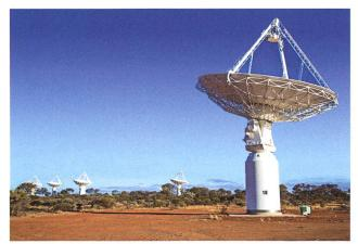
**Abb. 6:** Murchison-Observatorium in Westaustralien. Das Bild zeigt 5 von insgesamt 36 Parabolantennen mit je 12 m Durchmesser, die zu einem Radioteleskop-Array zusammengeschlossen wurden, dessen Auflösung einer Antenne mit etwa 6 km Durchmesser entspricht. Bild: Australia Telescope National Facility
