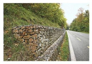
**Abb. 2:** Gabionen, Steinkörbe entlang einer stark frequentierten Strasse.
