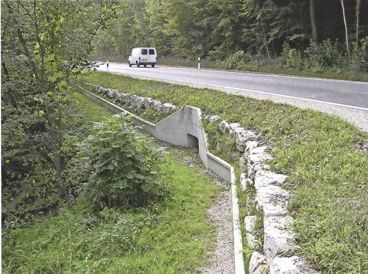
Abb. 51: Vor grösseren Sanierungsarbeiten an Kantonsstrassen wird jeweils die Notwendigkeit des Einbaus von Durchlässen geprüft, damit Kleintiere wie insbesondere Grasfrösche und Erdkröten sicherer auf die andere Seite der Strasse gelangen. Dies ist Ausdruck der guten verwaltungsinternen Zusammenarbeit zwischen den für den Strassenunterhalt und den Naturschutz zuständigen Amtsstellen. (Foto: André Stapfer)
