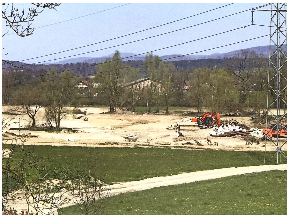
Abb. 25: Nach der abgeschlossenen Landumlegung und der Projektierung begannen im August 2019 die Bauarbeiten des Auenregenerationsprojekts Sins-Reussegg. Die neue Aue soll verschiedene Lebensräume beinhalten: von Uferanrissen und Flachufeln über Sand- und Kiesbänke, Tümpel und Weiher bis zu artenreichen Wiesen und Weiden, Hochstaudenfluren und Gehölzgruppen. An der Finanzierung beteiligen sich der Bund, der naturemade star-Fonds des Kraftwerks Wettingen (ewz Zürich), die Pro Natura und der Kanton Aargau. (Foto: Susanne Gfeller)
