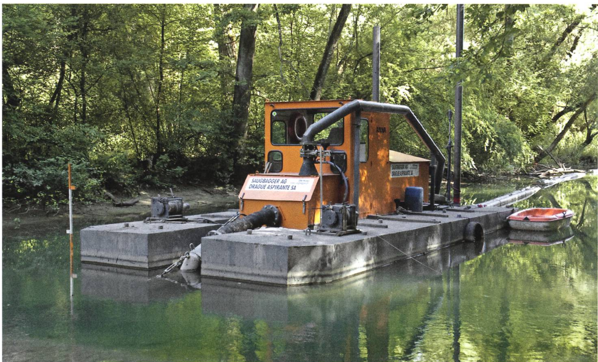
Abb. 29: Für die Aufwertung und Pflege artenreicher Lebensräume sind hauptsächlich Bauunternehmungen, Landwirtschaftsbetriebe und Forstämter im Einsatz. (Foto: Susanne Gfeller)
