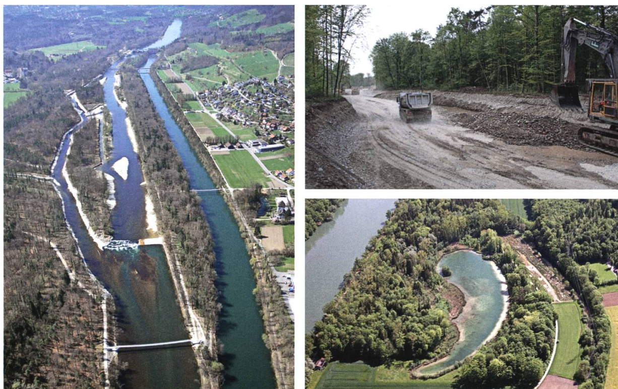
Abb. 31: An der Aare zwischen Aarau und Wildeggen wurden zwischen 2003 und 2012 vier grosse Aufwertungsprojekte realisiert. Die Abbildung oben rechts zeigt die Bauarbeiten zum Projekt «Dynamische Flussaue». Kernstück sind ein 1,5 km langer Seitenarm. In diesem neben dem Auenprojekt Reussegg in Sins bis heute grössten und komplexesten (siehe Kap. 4.3, Erfolgsfaktoren) Projekt des Auenschutzparks war auch die Erholung ein wichtiges Thema. So wurden u. a. zwei Spannbandbrücken erstellt, die eine attraktive Rundwanderung um das aufgewertete Gebiet ermöglichen (Bild links). Die Abbildung unten rechts zeigt den im Jahr 2004 fertiggestellten, vom Grundwasser gespeisten, über 300 m langen Altarm «Aarschächli». (Foto links: Oekovision GmbH, Widen, 2. April 2012; Foto rechts oben: André Stapfer, 17. Mai 2010; Foto rechts unten: Oekovision GmbH, Widen, 11. Mai 2012)
