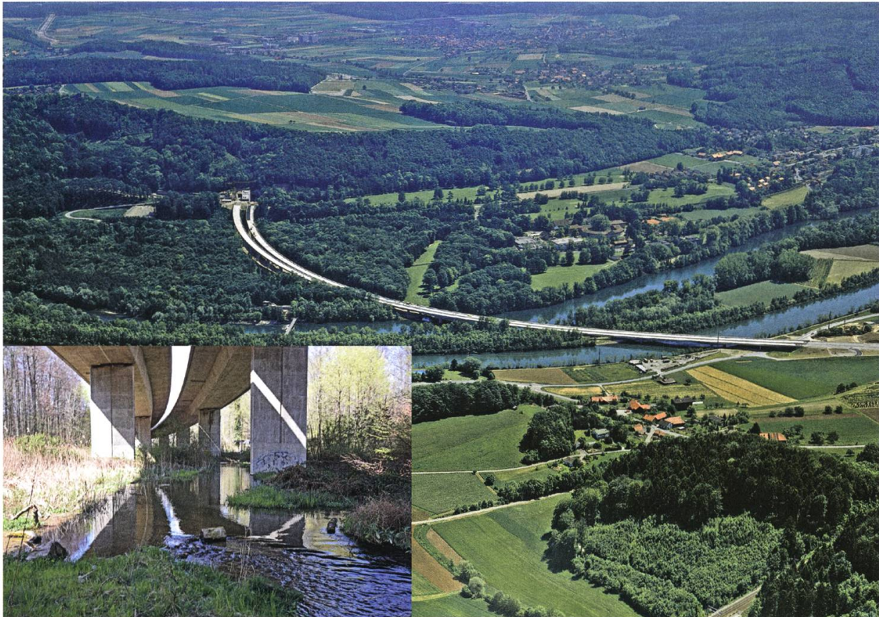
Abb. 16: Aaretalquerung der Autobahn N3 (heute A3) mit einer durchlässigen, tiefliegenden Brücke anstelle des ursprünglich geplanten Dammes. Der Einpassung in die Landschaft und dem ökologischen Ausgleich wurde für diese Zeit relativ viel Gewicht beigemessen. Die Aufnahme entstand 1993, drei Jahre vor der Eröffnung dieses Autobahnabschnittes. Auf der orographisch rechten Flussseite wurde als einer der verlangten Kompensationen ein fischgängiges, aquatisches System erstellt. Das Inset-Bild zeigt das im Rahmen des ökologischen Ausgleichs erstellte Feuchtgebiet («aquatisches System» genannt), das heute zahlreichen Fischarten Lebensraum bietet. (Fotos: ETH-Bibliothek Zürich, Bildarchiv, Fotograf: Somorjai Zsolt; André Stapfer, Inset)
