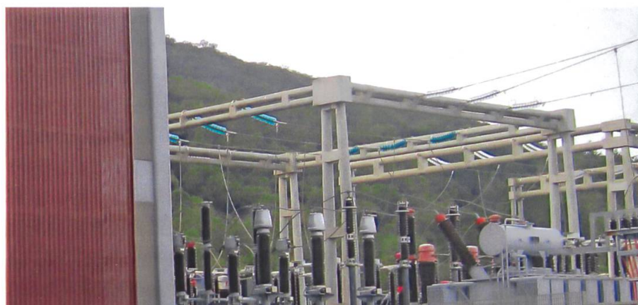
Abb. 26: Transformator und Stromverteilung im geothermischen Kraftwerk Sasso II in Larderello / Foto: M. Eberhard
