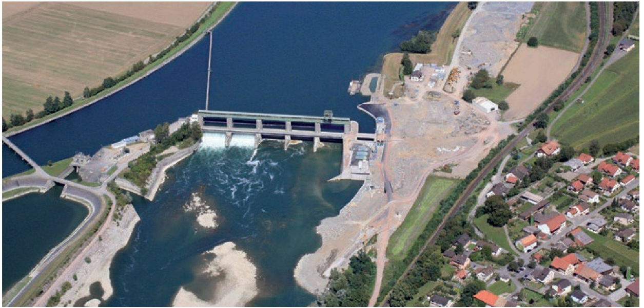
Abb. 14: Neues Dotierkraftwerk RADAG am Hochrhein auf der Höhe Leibstadt / Dogern (2010). (Quelle: RADAG/Schluchsewerke AG, Laufenburg D)
