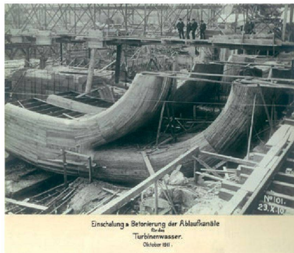
Abb. 5: Einschulung und Betonierung der Ablaufkanäle für das Turbinenwasser – Kraftwerk Augst, Stand Oktober 1911. (Quelle: Kraftwerk Augst AG)
