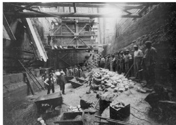
Abb. 6: Baugrube bei Schwelle Nr. 6, Kraftwerk Augst. (Quelle: Kraftwerk Augst AG)
