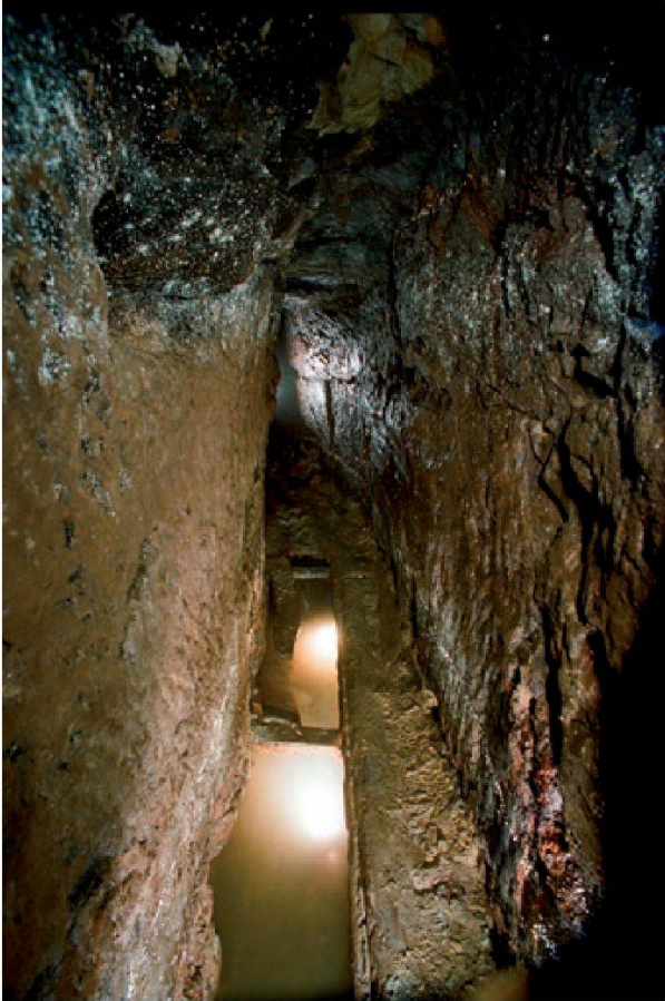
Abb. 1: Meyersche Stollen in Aarau. (Quelle: Foto Schatzmann, Aarau)
