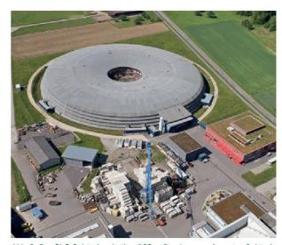
Abb. 3: Das SLS-Gebäude mit über 100 m Durchmesser. Im roten Gebäude rechts ist das Kontrollzentrum untergebracht. Foto: PSI.
