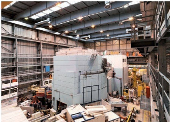
Abb. 10: Die Neutronenquelle SINQ erzeugt intensive Neutronenstrahlen. Dazu wird der PSI-Protonenstrahl im Zentrum der SINQ auf ein Bleitarget gelenkt. Bild: PSI.
