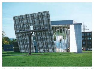
Abb. 19a: Solarofen. Ein beweglicher Flachspiegel (Heliostat) von 120 m² lenkt die Sonnenstrahlung auf einen Parabolspiegel. In seinem Fokus wird sie 5000-fach konzentriert und erzeugt rund 2000°C zur Untersuchung chemischer Hochtemperatur-Prozesse.
