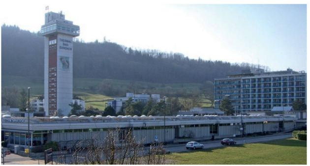
Abb. 9: Ansicht Bad Zurzach, Thermalbad. Der 1963 erbaute Turm ermöglicht die Druckregulierung des ausfliessenden Thermalwassers
