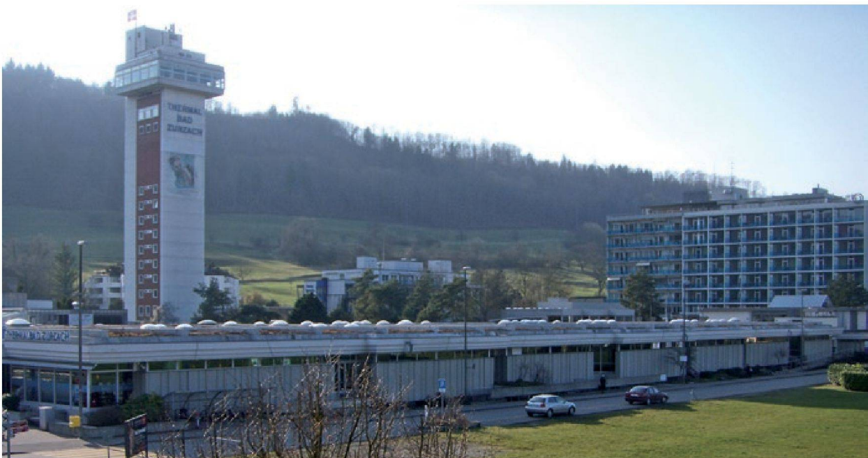
Abb. 9: Ansicht Bad Zuzach, Thermalbad. Der 1963 erbaute Turm ermöglicht die Druckregulierung des ausfliessenden Thermalwassers
