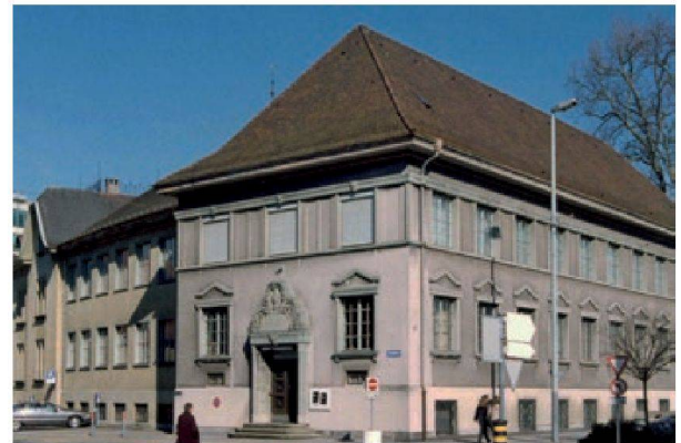
Abb.1: Das Aargauische Naturmuseum, wie es bis 1998 ausgesehen hat; rechts das Hauptgebäude aus dem Jahr 1922, nach links anschliessend der Verbindungsbau mit Vortragssaal aus den 1950er Jahren, ganz links die alte Villa Hunziker. Nur das Hauptgebäude blieb beim Umbau in das Naturama (1998-2002) erhalten. Foto: Foelix
