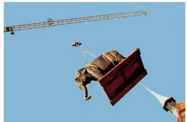
Abb.2: Während des Umbaus musste die gesamte Sammlung ausgelagert werden. Hier der Abtransport des berühmten Elefanten, der im Zoo Basel seinen Wärter getötet hatte, durch das Dach des alten Naturmuseums. Foto: Schäublin
