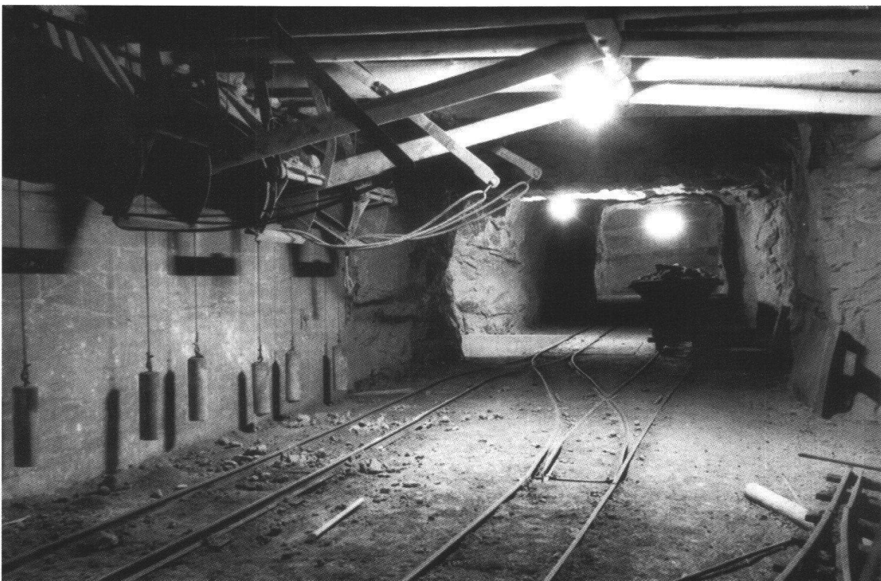
Abb. 7: 1999 Förderstrecke in der Sohle C. Die Stollen weisen alle die Dimension von 6,5 m Breite und 5,0 m Höhe auf.
