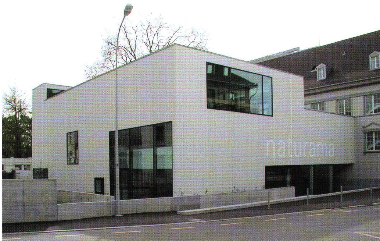
Abb. 1: Naturama – das neue Aargauer Naturmuseum, eröffnet am 19. April 2002. Der Neubau enthält alle Ausstellungsräume sowie Schulungs- und Vortragsaal. Der Altbau blieb erhalten und beherbergt die Sammlungen und Administration. Foto: A. ROHNER.
