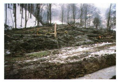
Abb. 14: Schlammfächer gegen die Benkerstrasse hin. Auf der Foto wird ersichtlich, wie sich die Schlammmasse aus dem engen Tal im Hintergrund gegen die Benkerstrasse fächerartig ausbreitet. Der Fischbach im Vordergrund wurde schon um den Schlammfächer herumgeführt.
