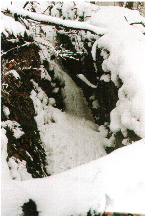
Abb. 7: Anriss auf der Felskrete des Brunnenberges.
