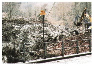
Abb. 15: Schlammfächer im Strassenbereich. Die Arbeiten im Vordergrund verdeutlichen, wie die Eindolung des Fischbaches voranschreitet.
