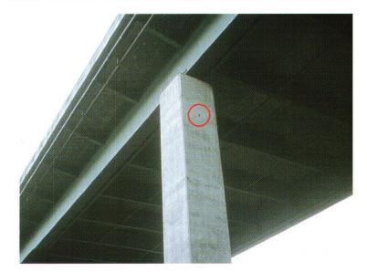
Abb. 7: Autobahnviadukt über die Reuss zwischen Birmenstorf und Mülligen; in jedem Pfeiler befindet sich ein Fledermausquartier. Das Lüftungsloch, welches als Ein-/Ausflug benutzt wird, ist rot markiert.
