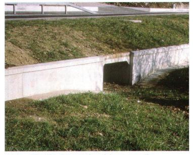
Abb. 17: Ein Betondurchlass ermöglicht nicht nur Amphibien, sondern auch anderen Kleintieren ein gefahrloses Überqueren von Strassen.
